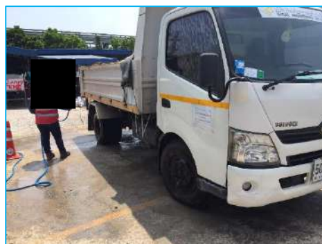
ภาพที่ 2-5 การทำความสะอาดรถบรรทุก/กำหนดจุดล้างล้อรถ
