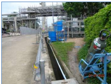
ภาพที่ 2-7 บ่อดักเศษตะกอนในพื้นที่ก่อสร้าง
