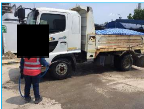
ภาพที่ 2-5 การทำความสะอาดรถบรรทุก/กำหนดจุดล้างล้อรถ
