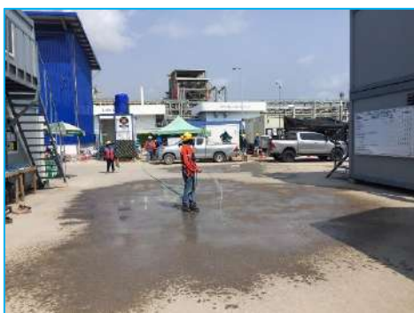
ภาพที่ 2-3 การฉีดพรมน้ำบริเวณพื้นที่ก่อสร้าง และถนนทางเข้าพื้นที่ก่อสร้าง
