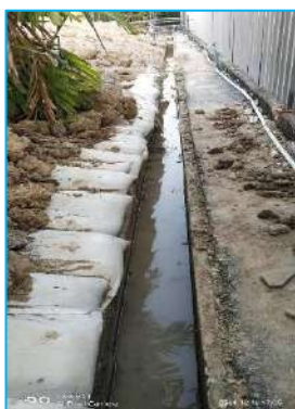
ภาพที่ 2-9 รางระบายน้ำฝนในพื้นที่ก่อสร้าง
