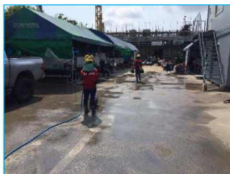
ภาพที่ 2-3 การฉีดพรมน้ำบริเวณพื้นที่ก่อสร้าง และถนนทางเข้าพื้นที่ก่อสร้าง
